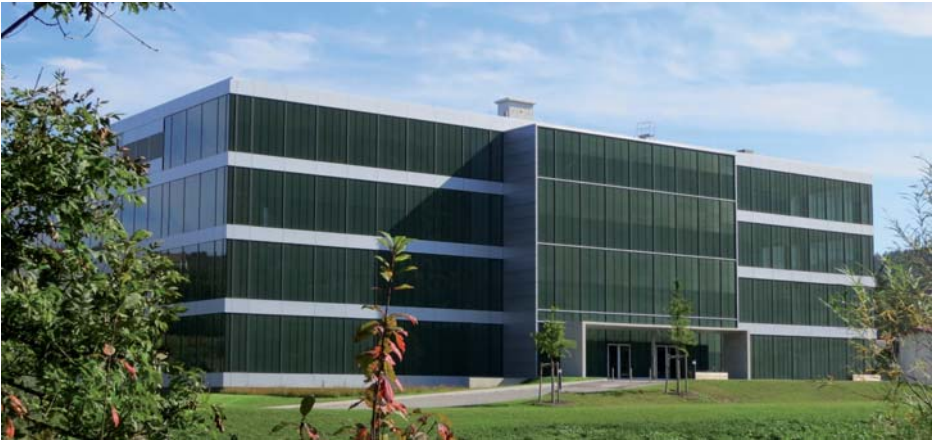
Abb. 22: Pharma 2020 Neubau Produktion, Sulzbach-Laufen. Arch: Koppenhöfer + Partner GmbH, Stuttgart. Alu-Konstruktion mit Tageslichtlenkung Typ RETROLuxTherm 20 mm im Isolierglas in Kombination mit einer Verglasung 50/25, ideal für großflächige Fassaden.
