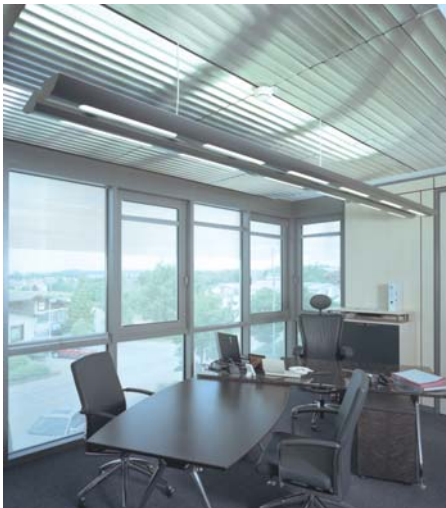
Abb. 43: Umlenkschema: Tages- und Kunstlicht wird an die Decke gelenkt und als Vertikalbeleuchtung auf den Schreibtisch gestrahlt.
