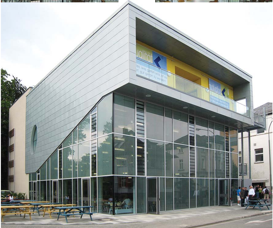
Abb. 21: Audi-Max und Mensa, FH Gießen. Arch.: BLFP Architekten, Friedberg. RETROLuxTherm 20 mm im Isolierglas. Vorteil: wartungsfrei, vor Vandalismus und Wind geschützt, keine Alterung, kein Verschleiß, gute Durchsicht.
