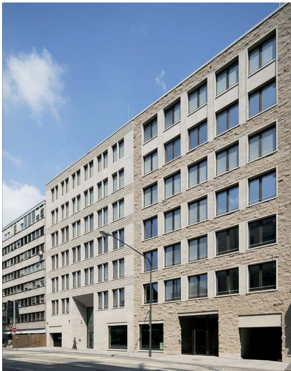
Abb. 38: Stiftung Waisenhaus, Frankfurt, Arch.: Braun Canton Volleth Architekten, Frankfurt. RETROFlex-Jalousie im Verbundfenster mit Passivhaus-Standard. Am Holzfensterflügel ist ein Aluminiumflügel mit einer Prallscheibe über Scharniere befestigt. Zwischen den Scheiben ergibt sich ein Schacht für die RETROFlex-Jalousie.
