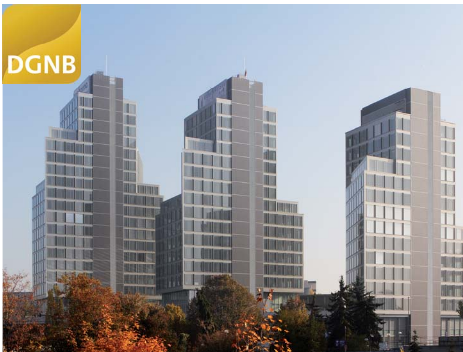
Abb. 31: Litex/Sopharma Triple Towers, Bürogebäude, Sofia, BG; Arch.: Dimitar Pascalev, Sofia, BG. Nicht-hinterlüftete, zweischalige Fassade mit Fresnel-Jalousien Typ RETROFlex 80 mm. U-Wert < 1,1 \text{ W/m}^2\text{K} , g-Wert \sim 0,05 - 1 bei hoher Sommersonne und offener Jalousie
