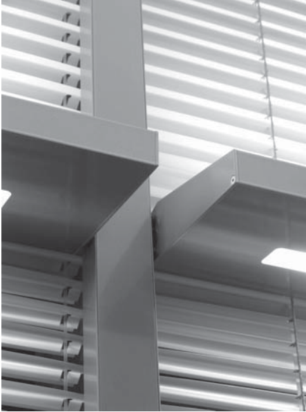
Abb. 45: Synergieeffekte durch die Integration von Tageslicht und künstlicher Beleuchtung. Schwächeres Tageslicht wird durch RETROLight ergänzt. Die elektrische Beleuchtung wird über die Unterseite der RETROLux oder RETROLuxTherm-Lamellen umgelenkt.
