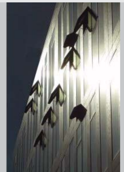
Lamellenposition bei Sonneneinfall < 15^\circ Louver position for angle of incidence < 15^\circ
